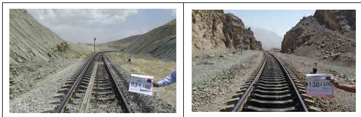
【図 2-6】測量作業前の現地踏査
