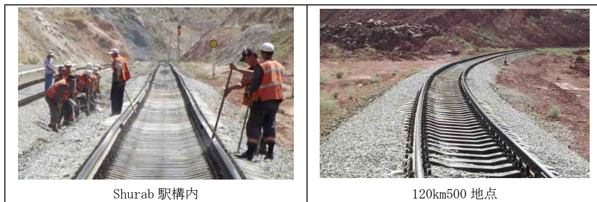
【図 2-16】 バラスト交換作業の状況
