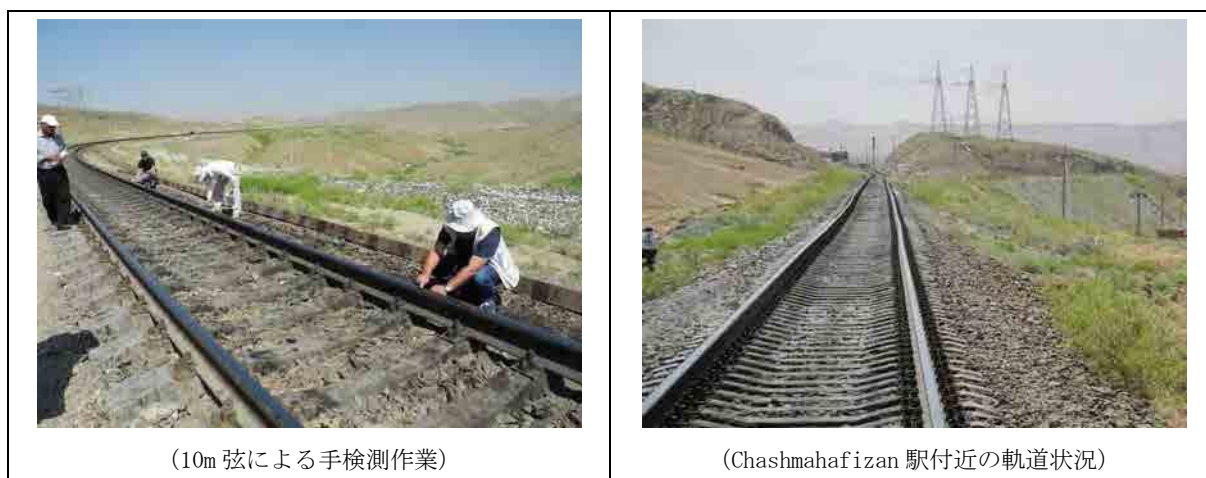
【図 2-4 軌道現状調査の作業状況】
