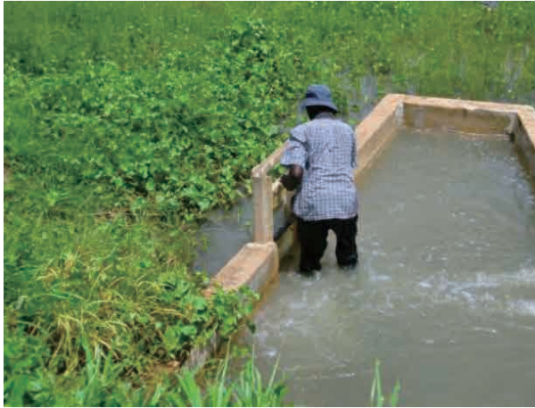
ファティック州：FAO、スペイン、南アフリカ、セネガルが資金供与している「ヌディオディウフ小規模水利施設整備計画」の作業風景
