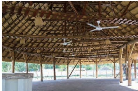
ダイニングホール内部
