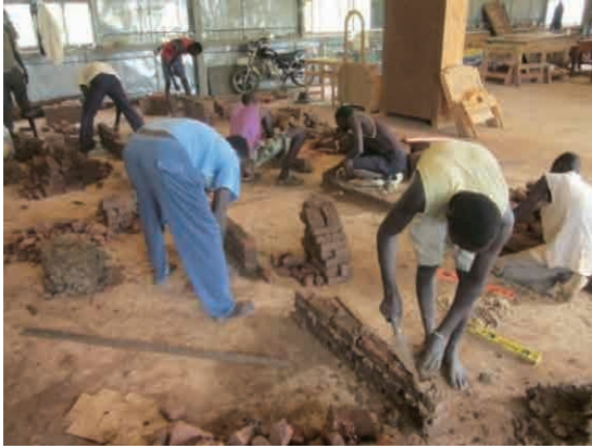
建築学科：レンガ組積試験
