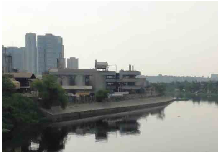
計画堤防敷地内に立地する D & L Industries, Inc.
