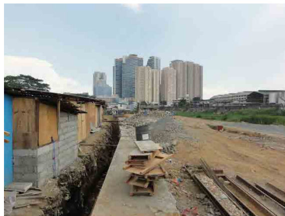
サントーラン地区の整地された河岸と建設中の護岸
