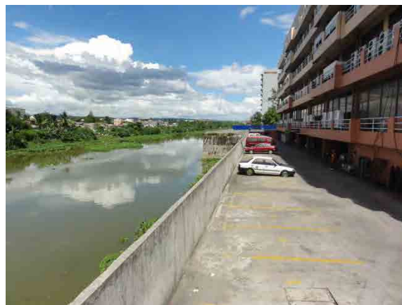
民間のパラペットは一般的であり、河道への張り出しも多い
