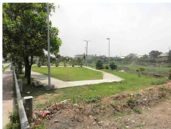
施設は河川管理区域内に建設されている
