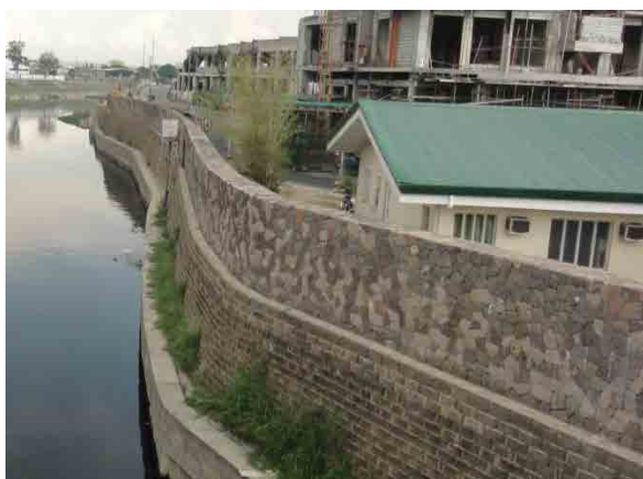
ロザリオ堰上流部のシルクロヴェルデ河岸擁壁
