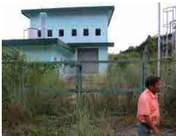
Region III/Pampanga Delta 灌漑事業 / ポンプ場
