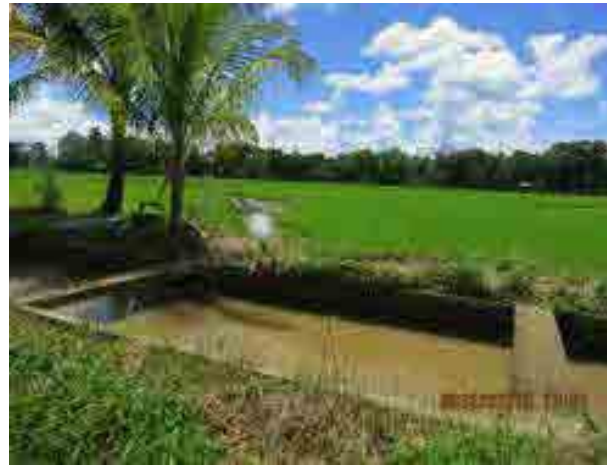
Region VI/Mambusao 灌漑事業 / 幹線水路
