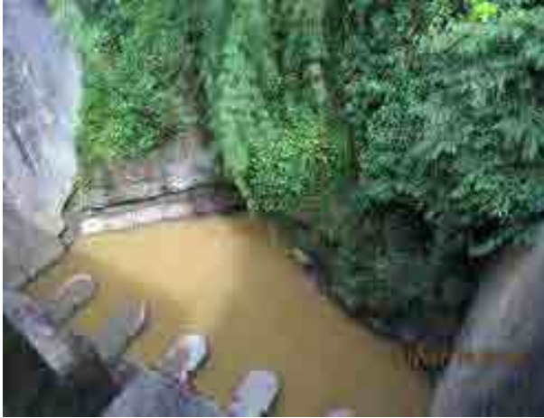
Region I/Amburayan 流域灌漑事業 / 幹線水路への暗渠
