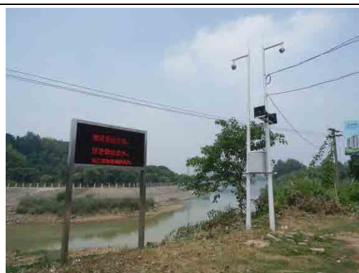
日本から提供された陸水ダムの下流警報機材
