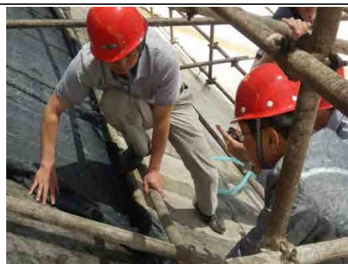
凍結融解工事の施工について協議する 中国側C/Pと日本人専門家
