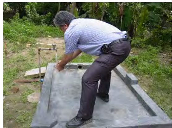
バングラデシュ水供給プログラム・プロジェクト（BWSPP）における、ケラニガンジ地区のパイプ給水先（家庭）
