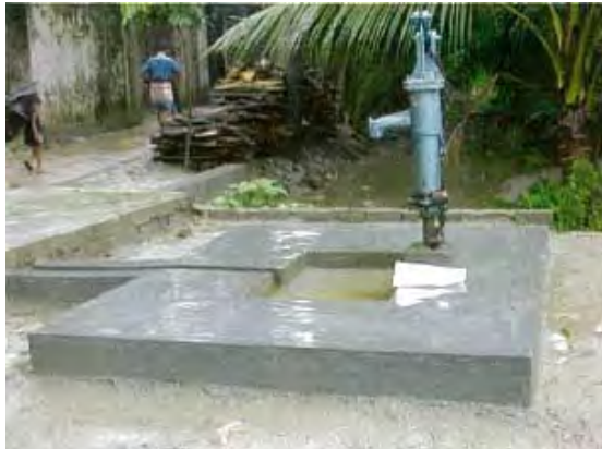
深井戸（掘り抜き井戸）
