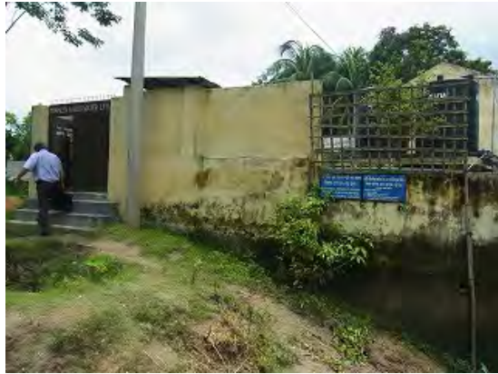
グラミン・ベオリア・ウォーター社が運営している浄水場（ダッカ地区ゴアルマリ村）
