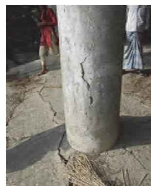
写真 3-30 柱の縦亀裂
