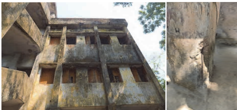
写真 3-23 老朽化したサイクロン・シェルター(左) むき出しになった鉄筋(右)
