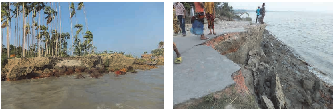
写真 3-37 侵食の著しい地域の状況
