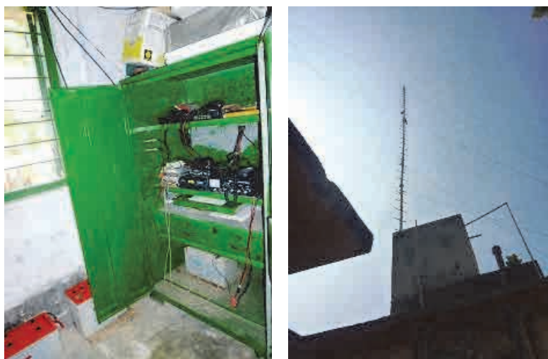
写真 3-27 無線機(左)とアンテナ(右)
