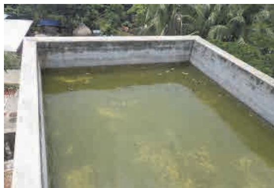
写真 3-33 清掃が不十分な雨水貯水槽
