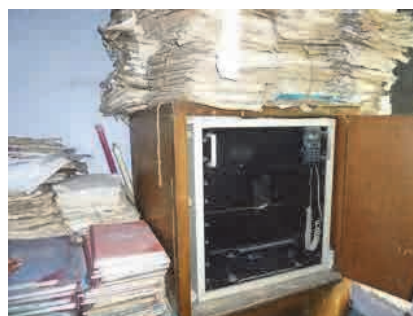
写真 3-1 5 年前に故障した HF 無線装置(Mongla 郡(Upazila))
