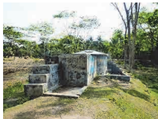
写真 3-29 飲料水用池とろ過装置(ポンプが壊れ使えない状態であった)
