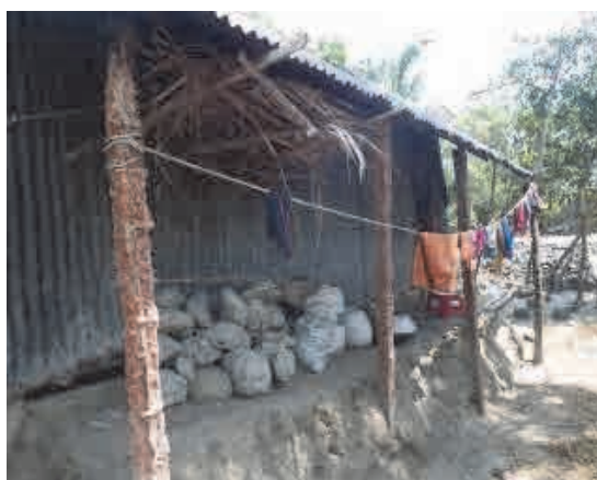
写真 3-20 腐食が著しい支柱
