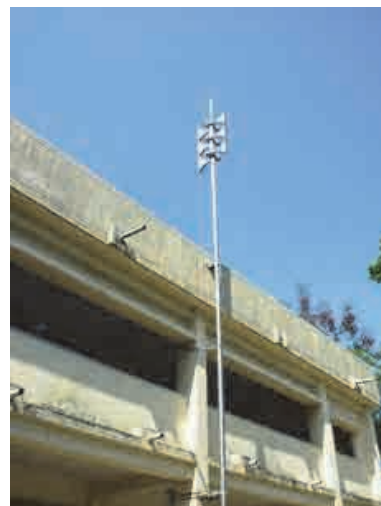
写真 3-15 メガフォン-サイレンシステム(スピーカー)
