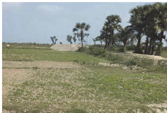
写真 3-25 修復中の輪中堤
