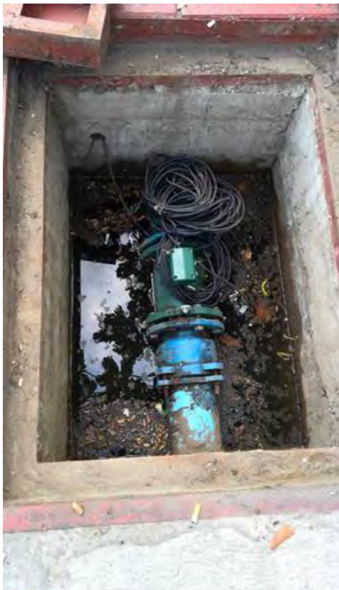
図 2-6-7. DMA の設置確認
