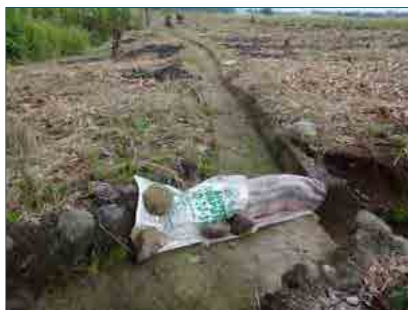
写真2-16 農家が自力設置した三次水路（シピンベ）
