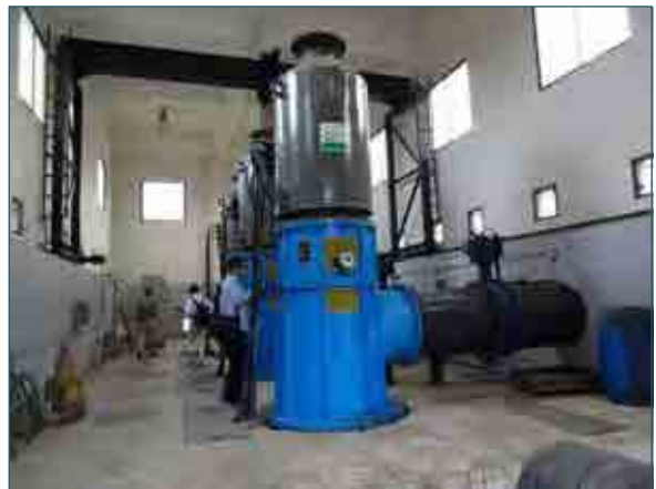
写真 2 - 10 揚水機場内部
