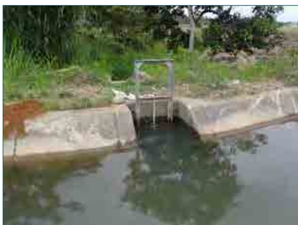
写真2-15 三次水路分水工（シピンベ）
