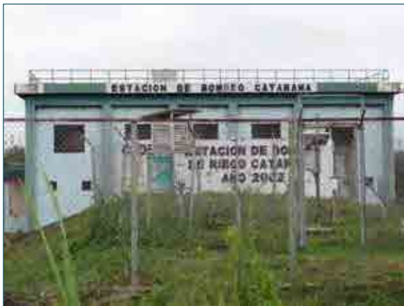
写真 2 - 9 揚水機場外観
