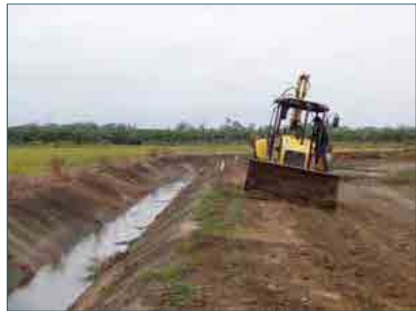
写真2-12 二次幹線水路維持管理作業
