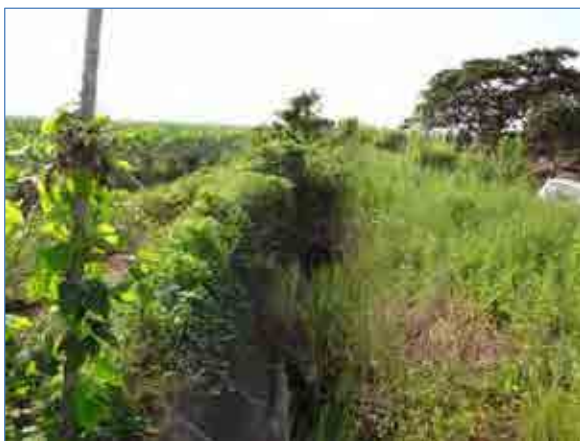
写真2-13 二次水路の流末維持管理状況
