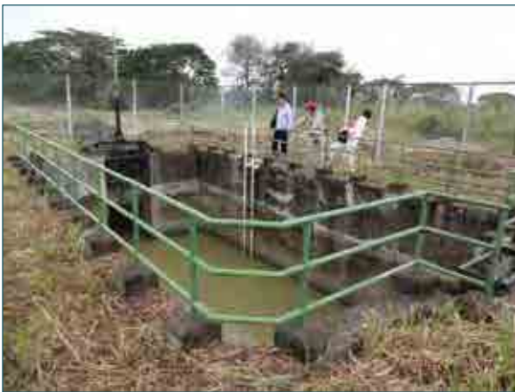
写真2-11 幹線導水路（管路）出口・分岐
