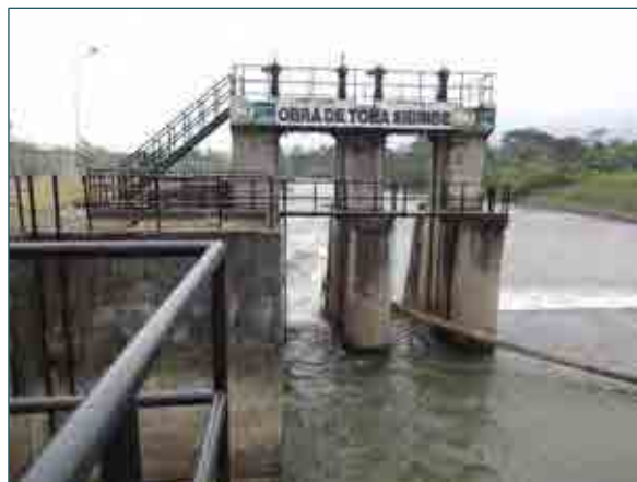
写真 2 - 2 堰上流より土砂吐ゲート
