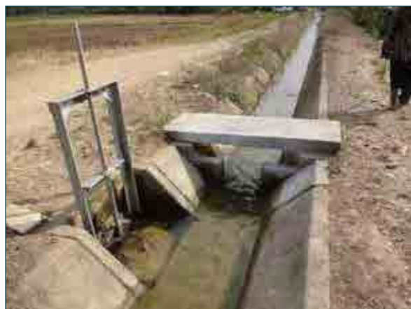
写真2-17 三次水路分水工（シピンベ）
