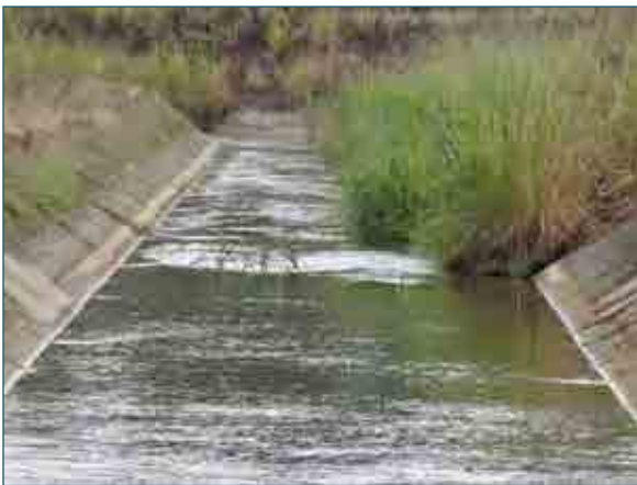
写真2-3 幹線導水路（雑草除去済～未着手）
