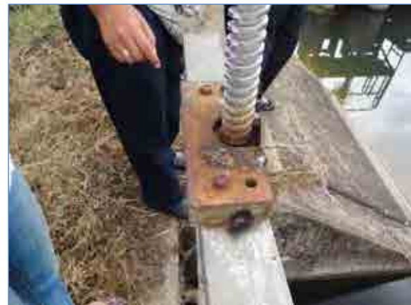
写真2-6 水利費不払い対策（ゲート溶接）
