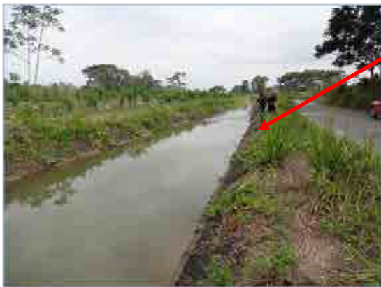
図 2 - 10 不適切な分水工1
