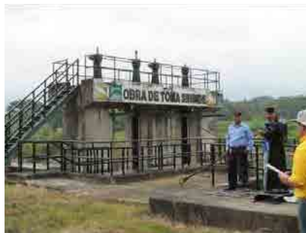
シピンベ地区の頭首工
