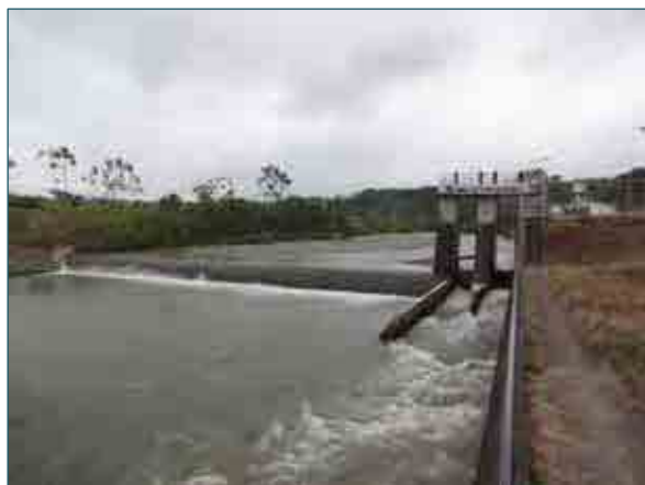
写真 2 - 1 頭首工（下流より全景）
