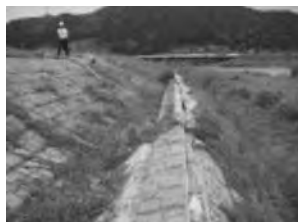
[Tham khảo 2] Điều chỉnh nền lún bằng láng phủ đường và xây tường bao giữ
