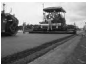
[Tham khảo 2] Điều chỉnh nền lún bằng láng phủ đường và xây tường bao giữ
