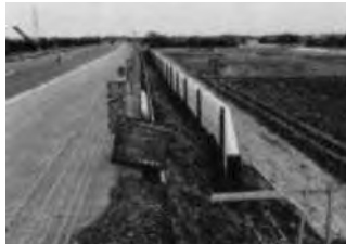
[Tham khảo 2] Điều chỉnh nền lún bằng láng phủ đường và xây tường bao giữ
