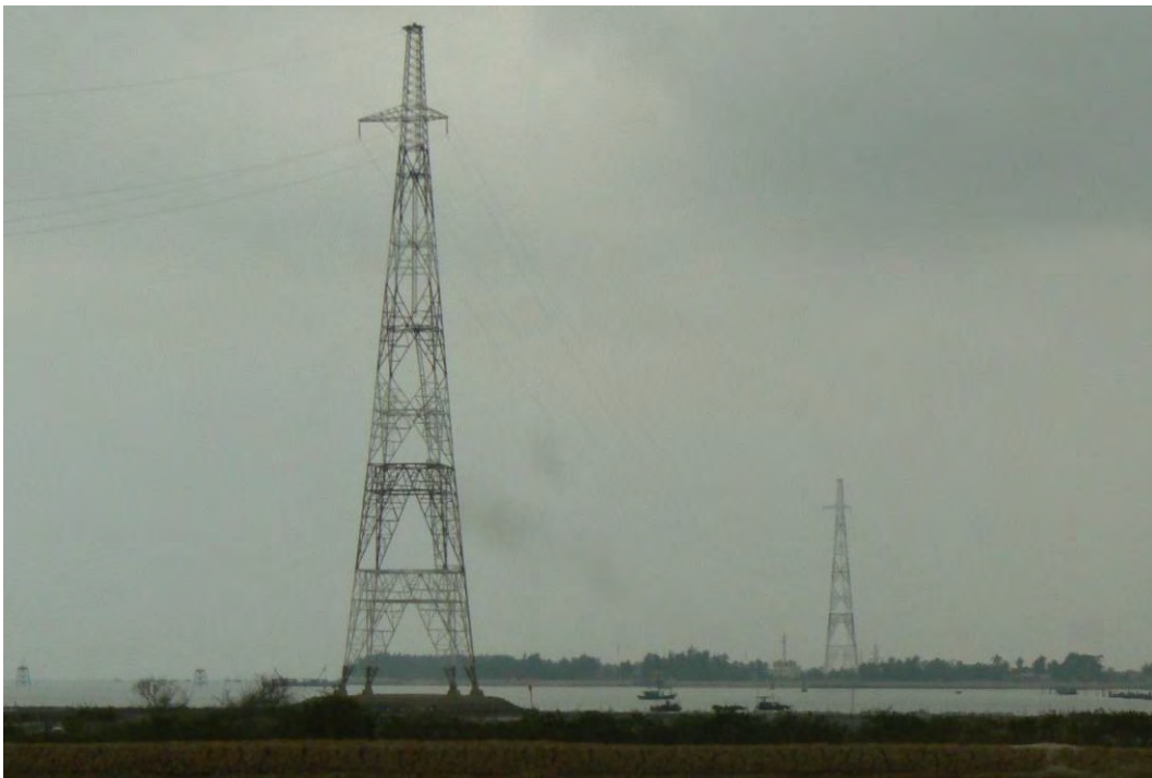
Ảnh chụp cột tháp điện và đường cáp điện cao thế vắt ngang qua luồng. Ảnh chụp từ đảo Cát Bà. Có thể nhìn thấy phía Cát Hải từ xa.
