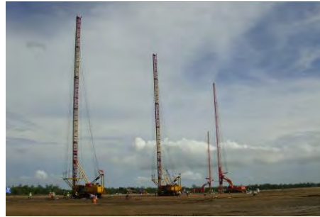
Máy thi công PVD (40m)
