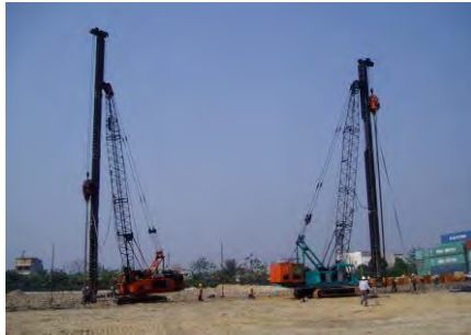
Máy thi công PVD (20m)
