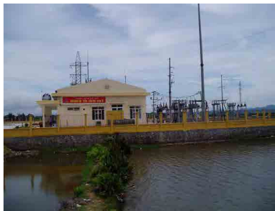
Ảnh 2 Trạm biến áp mới ở đảo Cát Hải
