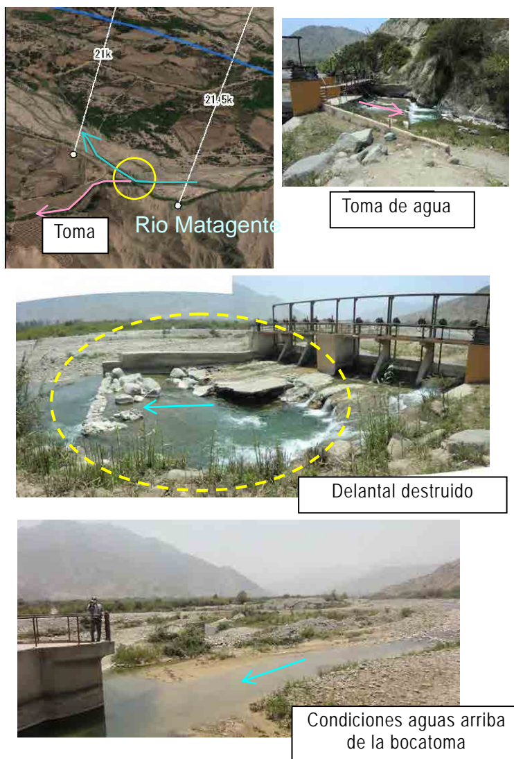
Figura 3.1.6-11 Condiciones locales relacionadas con el Desafío 2 (Río Chíncha)
