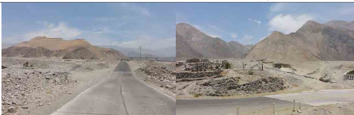
Figura 3.1.8-22 Carretera rural (=local) que cruza el río Cosos (en temporada de lluvia los sedimentos cubre la carretera rural, sin embargo se restaura en un día)
