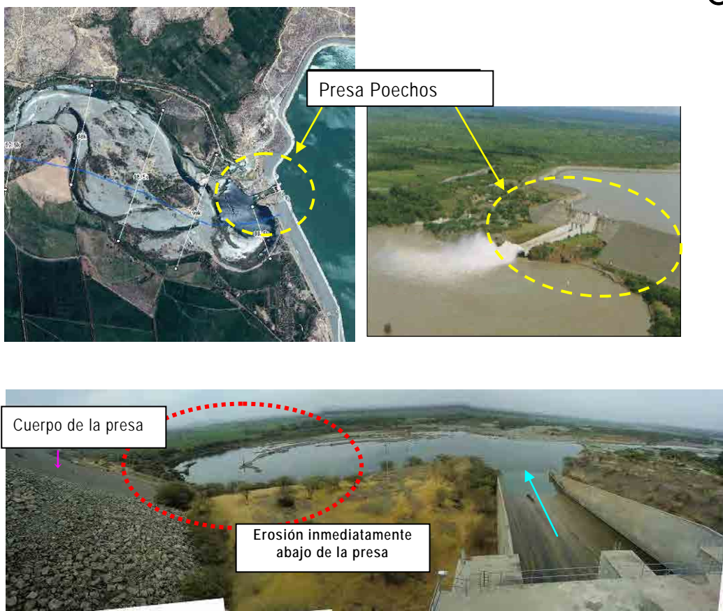
Figura 3.1.6-4 Condiciones locales relacionadas con el Desafío 3 (Río Chira)
