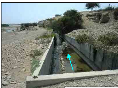
Canal de agua
