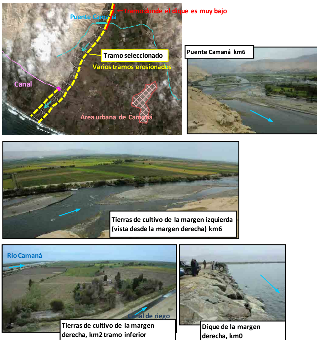
Figura 3.1.6-23 Condiciones locales relacionadas con el Desafío 1 (Río Camaná)
