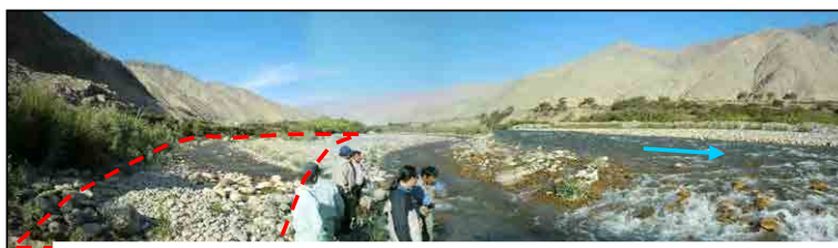
Tramo erosionado (km 25)
