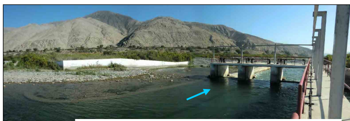
Bocatoma Nuevo Imperial (alrededor de km 24,5)
