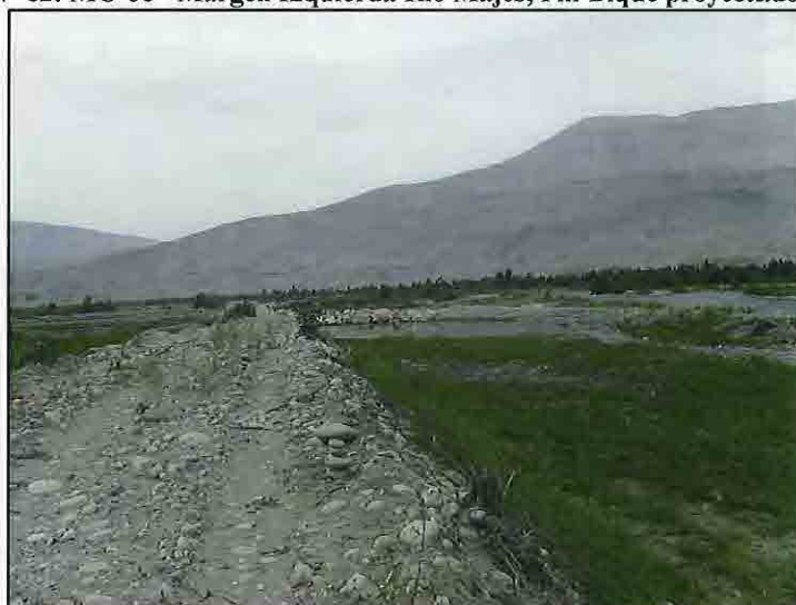
FOTO N° 62: MC-06 - Margen Izquierda Río Majes, Fin Dique proyectado (62+650)
