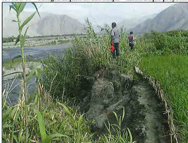
FOTO N° 63: MC-07 – Margen Izquierda Río Majes – Inicio Dique proyectado (64+680)
