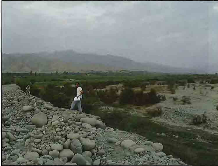
FOTO N° 44: Pi-06 - Margen Derecha Río Pisco – Dique proyectado, Poza de Regulación (34+820)
