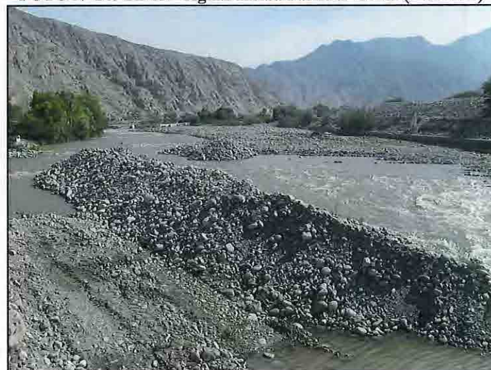
FOTO N° 24: Ch-03 – Aguas arriba Partidor Conta (> 24+000)
