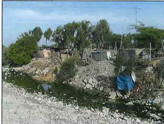
FOTO N° 3: Ca-01 - Margen Derecha Río Cañete – CC.PP. Urbanito (4+500)
