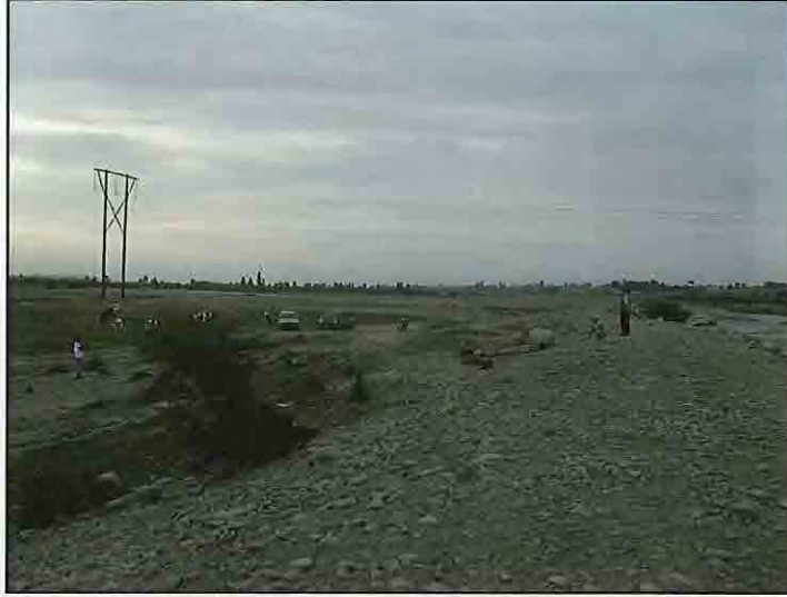
FOTO N° 43: Pi-05 – Margen Izquierda Río Pisco - Fin dique proyectado (26+700)
