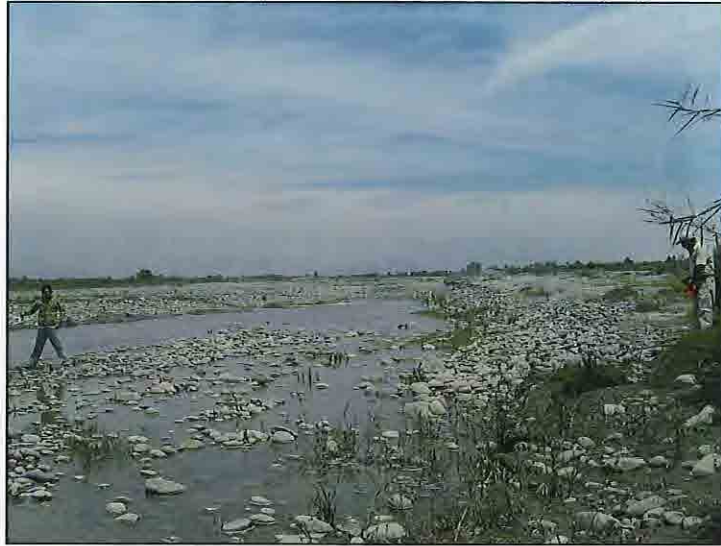
FOTO N° 37: Pi-03 – Margen Izquierda Río Pisco – Inicio dique proyectado (12+400)
