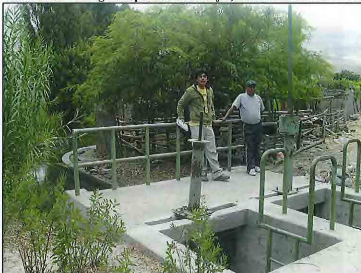
FOTO N° 61: MC-06 - Margen Izquierda Río Majes, Bocatoma Sarcas Torán (59+740)
