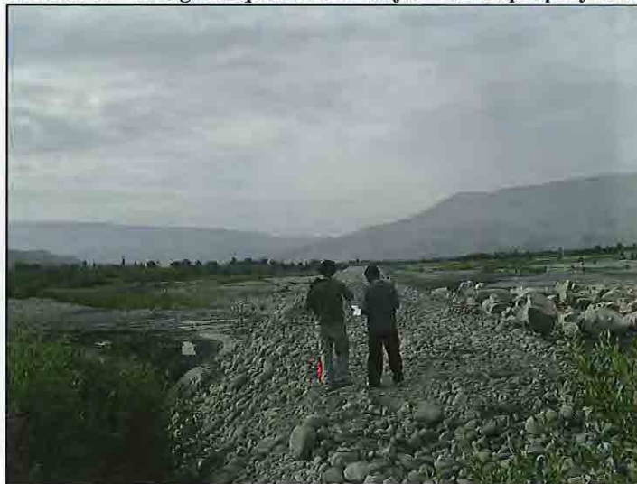
FOTO N° 67: MC-07 – Margen Izquierda Río Majes – Fin Dique proyectado (66+700)
