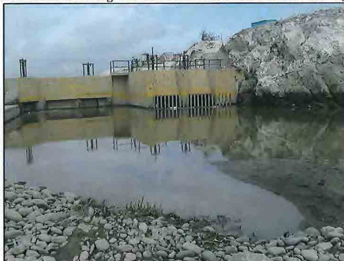
FOTO N° 36: Pi-02 - Margen Derecha Río Pisco – Bocatoma Caucato (6+740)
