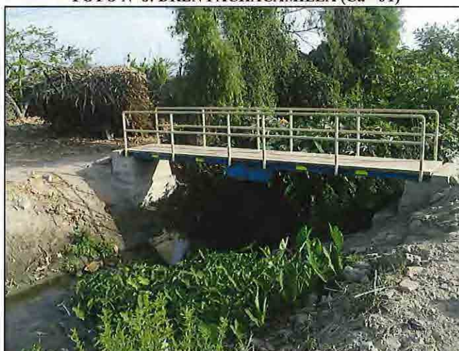
FOTO N° 8: DREN PACHACAMILLA (Ca - 01)
