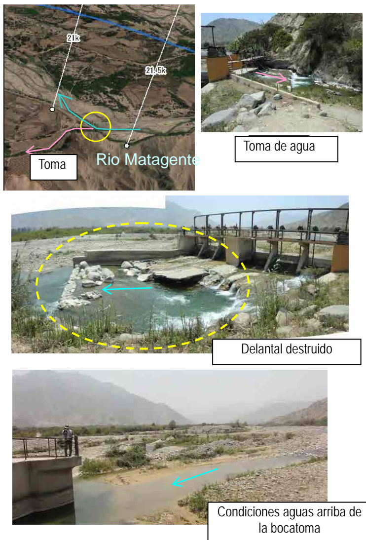
Figura 3.1.6-3 Condiciones locales relacionadas con el Desafío 2 (Río Chíncha)
