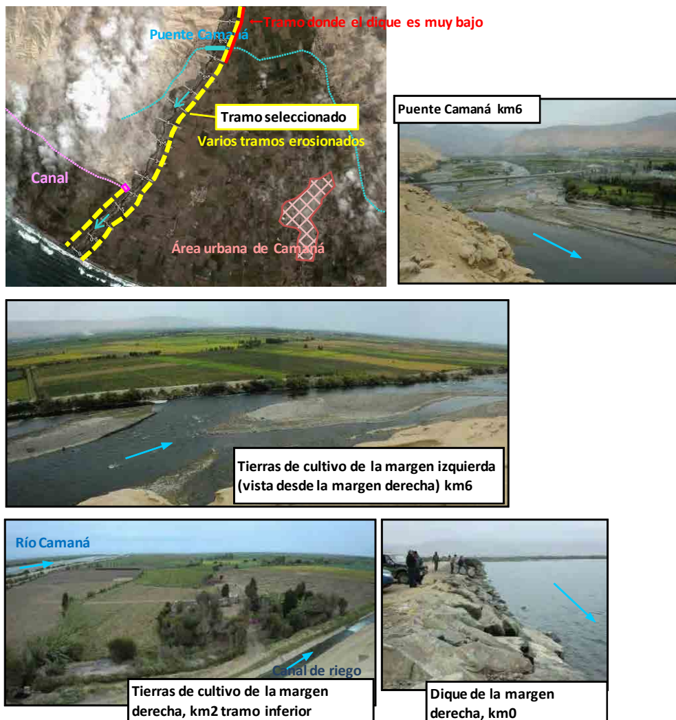
Figura 3.1.6-15 Condiciones locales relacionadas con el Desafío 1 (Río Camaná)
