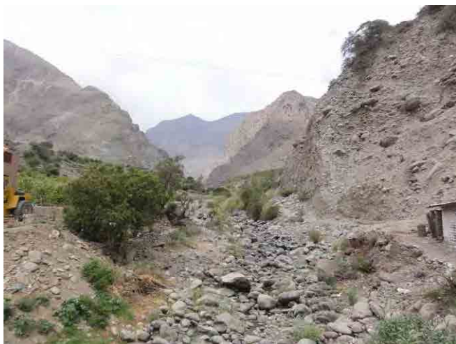
Figura 3.1.8-12 Tierras andesíticas y basálticas derrumbadas
