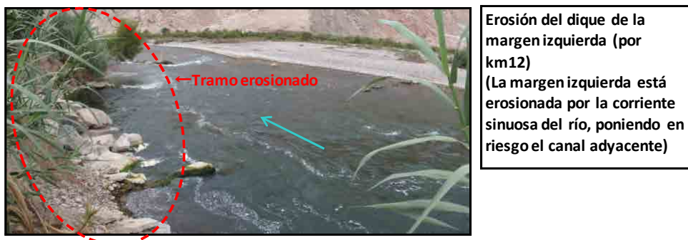
Figura 3.1.6-16 Condiciones locales relacionadas con el Desafío 2 (Río Camaná)
