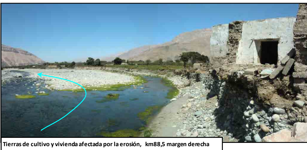
Figura 3.1.6-20 Condiciones locales relacionadas con el Desafío 6 (Río Majes)
