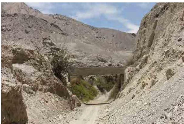
Figura 3.1.8-22 Situación de la deposición de sedimentos en el Río San Francisco (obstrucción de los canales de riego a causa del desastre. Las paredes de la carretera son los sedimentos de tierra y arena de ese entonces)
