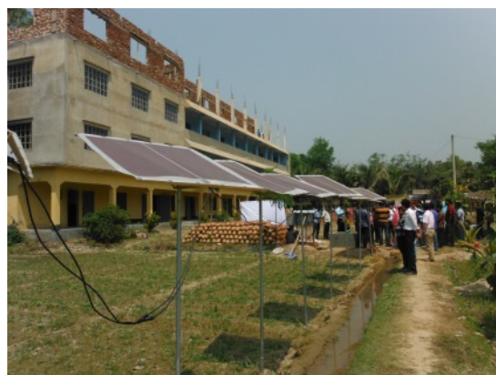
軽量太陽光パネルの特徴を活かした携帯型設置方法
