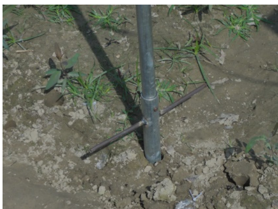
ポールの設置土台。設置所要時間は約2分
