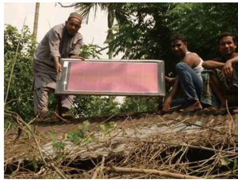
20Wのパネルを屋根に設置
