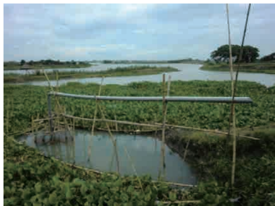
取水口（川から取水）
