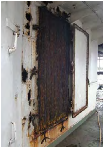
船尾甲板部の機関室排気ダクト
