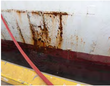
各所に外板の錆が顕著
