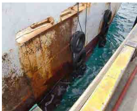
外板の塗料が剥げ、錆が浮いている
