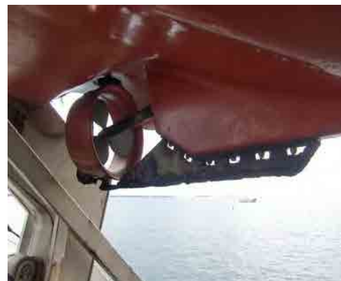
救命艇のスケグ金具が腐食
