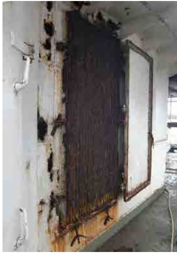
船尾甲板部の機関室排気ダクト
