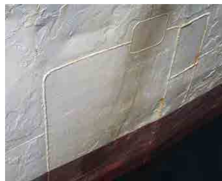
腐食外板の交換部
