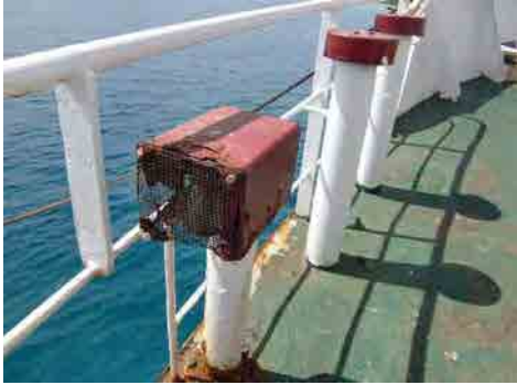
管頭部の腐食
