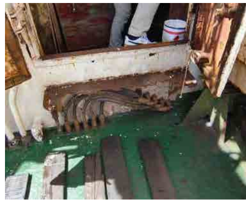
船首艙へのステップは錆落ちている
