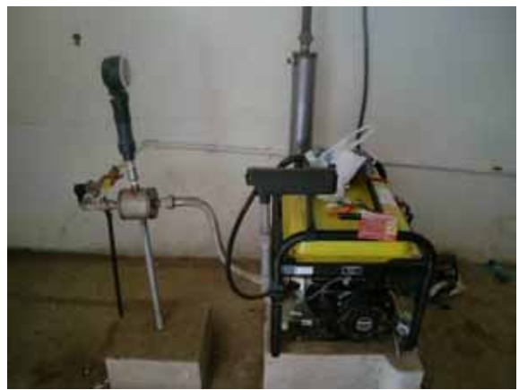
燃料供給系を改造した発電機
