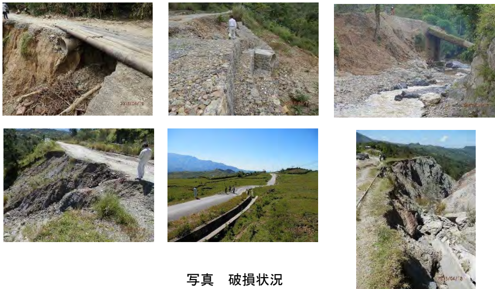
図-4 路体破損状況とその理由（全国道路網）
