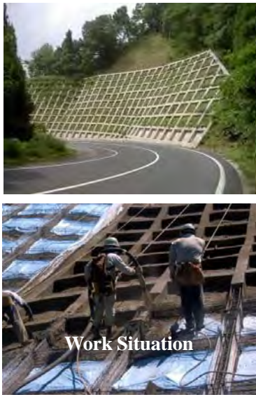
写真1 Grating crib method
