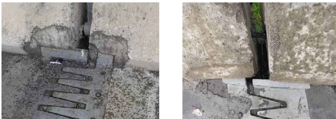
Hình 2.4-2 Cấu kiện ngăn nước không phù hợp ở hai đầu khe co giãn
