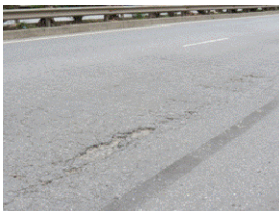
Sự suy giảm độ êm thuận do lún bề mặt cùng với sự phát triển của nứt
