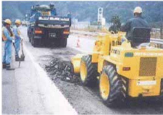
Gỡ bỏ lớp áo đường cũ và vận chuyển phế liệu bằng xe gầu xúc.
