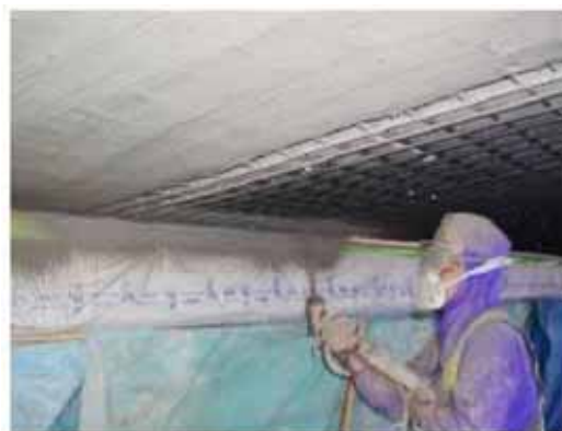
Hình 2.4-12 Vữa xi măng polyme sử dụng khí nén
