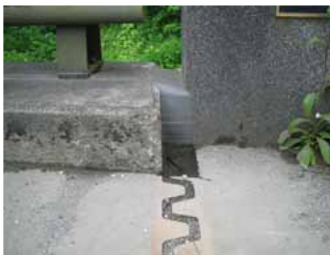
Hình 2.4-3 Cấu kiện ngăn nước phù hợp ở hai đầu khe co giãn
