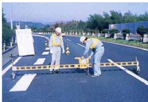
Đo lún vệt bánh xe bằng cách sử dụng thước đo trắc ngang
