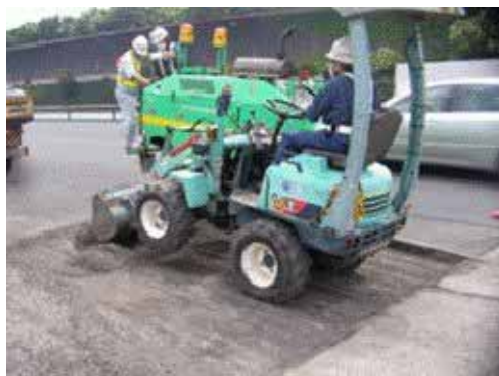
Vận chuyển vật liệu thải bằng máy gầu xúc
