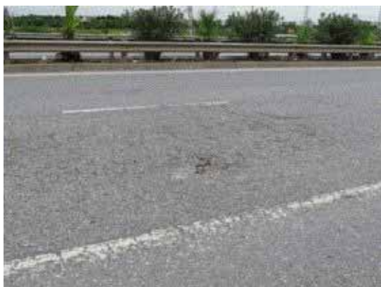
Nứt hai chiều (phát triển thành hư hỏng kết cấu)
