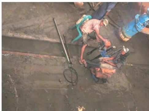
不等沈下でポンプベースにクラックが入り、地下水が侵入。侵入水のくみ出し作業。右奥は水をくみ出す床排水ポンプ。
