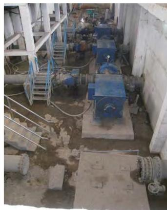
4台のポンプの内、手前1台は撤去され、奥の2台のポンプは大きな水漏れがある。
