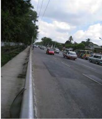
中央黒く盛り上がった部分が、口径 1,000 mm 鑄鉄管漏水修理跡。場所は交通量の激しい 6 車線の主要幹線道路。
