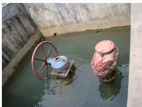
ポンプ吐出側配管右側空気弁左側制水弁、制水弁からの漏水で弁ピットは水浸し。
