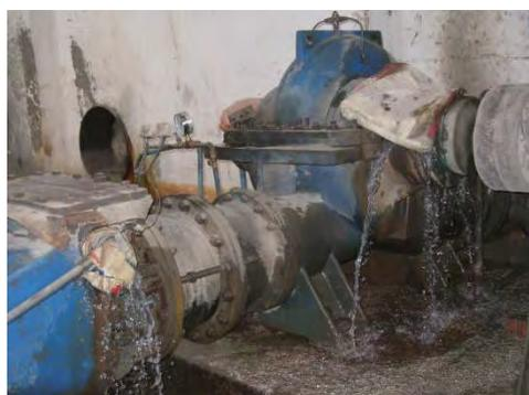
No.3ポンプグランド部及び写真左側逆止弁の亀裂部からの水漏れ。No.4もポンプグランドからの多量の水漏れがある。
