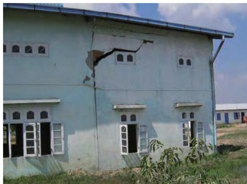
不等沈下のためにポンプ場北側壁面に大きなクラックが見える。
