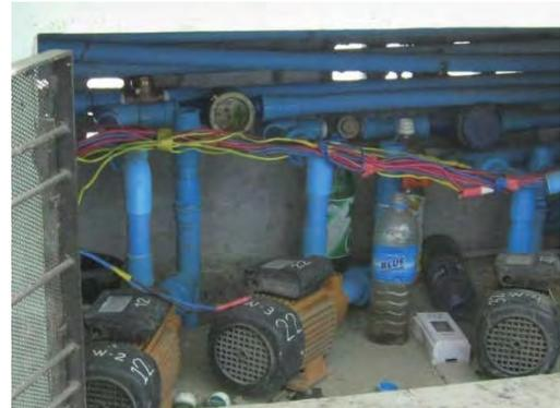
新築の住宅用水道メータ。高層住宅のために加圧用ポンプがある。(ブロック 1 ~ 6)
