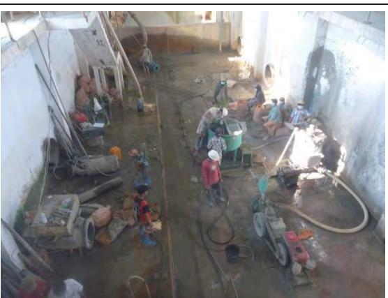
写真2-5 底版下へのセメントミルク注入工事 |
