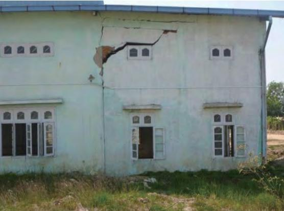
写真2-2 事務室東側壁の亀裂          |
