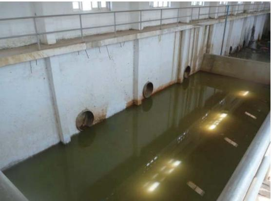
写真2-3 北側ブロックの浸水と奥の仕切壁   |
