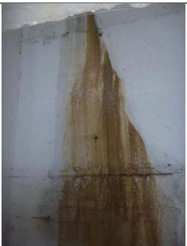
写真2-4 地下ポンプ室壁のひび割れからの浸水 |
