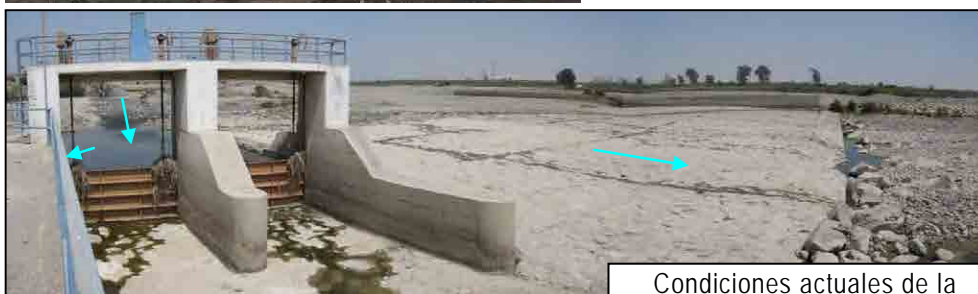
Condiciones actuales de la bocatoma existente
