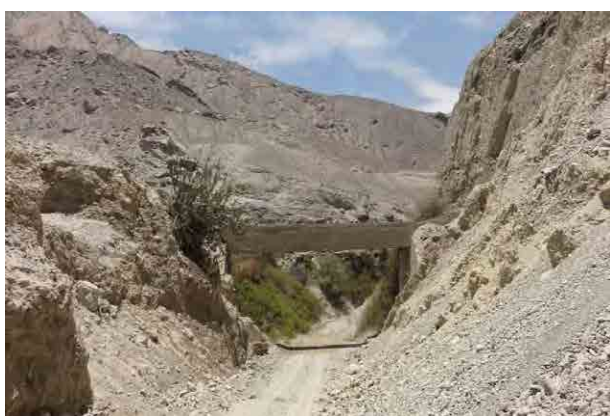
Figura 3.1.8-24 Situación de la deposición de sedimentos en el río San Francisco (obstrucción de los canales de riego a causa del desastre. Las paredes de la carretera son los sedimentos de tierra y arena de ese entonces)
