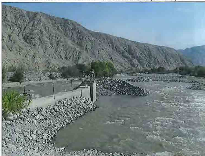
FOTO N° 22: Ch-03 – Partidor Conta (24+020)
