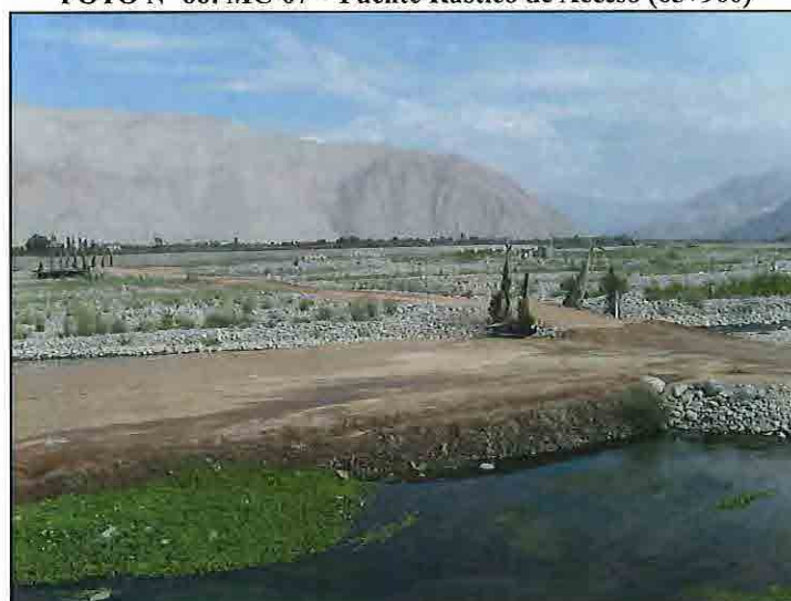
FOTO N° 66: MC-07 – Puente Rústico de Acceso (65+900)
