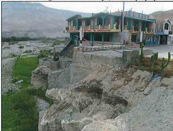
FOTO N° 59: MC-06 - Margen Derecha Río Majes, Inicio Dique proyectado (59+700)
