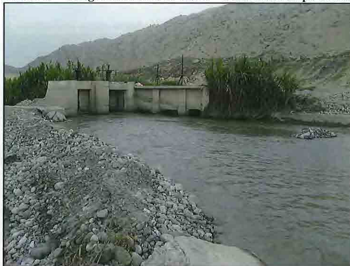
FOTO N° 19: Ch-02 - Margen Derecha Río Chico – Bocatoma Pampa de Ñoco (14+820)
