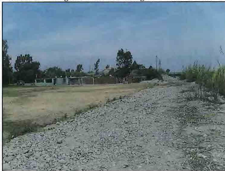
FOTO N° 29: Ma-02 - Margen Derecha Río Matagente – CC.PP. Chacarilla (8+600)
