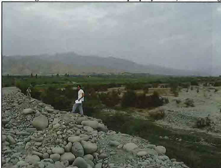
FOTO N° 44: Pi-06 - Margen Derecha Río Pisco – Dique proyectado, Poza de Regulación (34+820)
