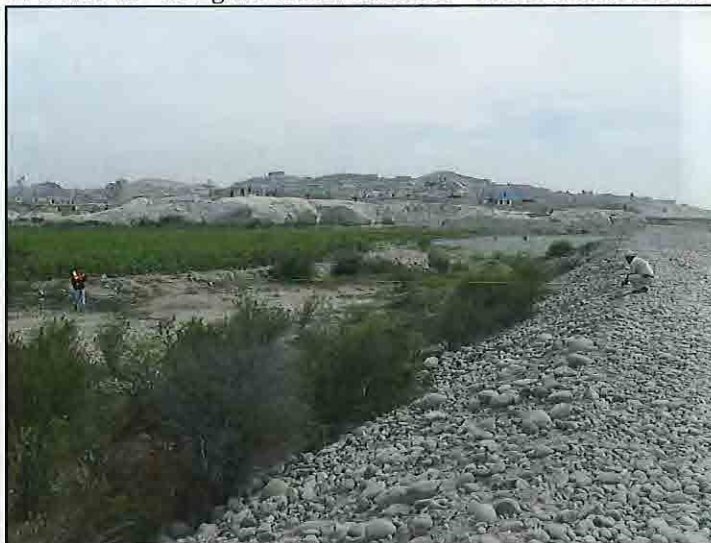
FOTO N° 34: Pi-02 – Margen Derecha Río Pisco – Inicio zona a forestar (6+400)
