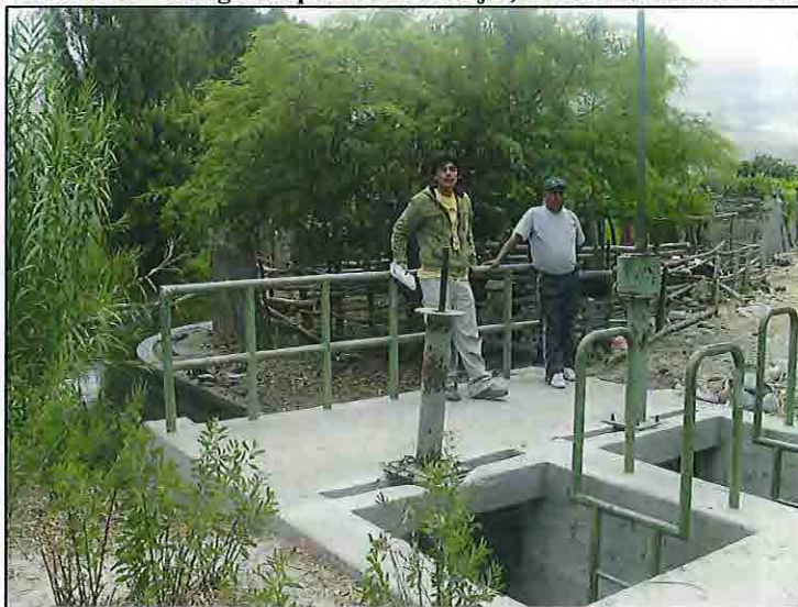
FOTO N° 61: MC-06 - Margen Izquierda Río Majes, Bocatoma Sarcas Torán (59+740)
