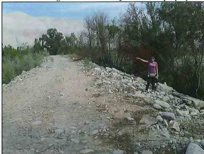
FOTO N° 64: MC-07 – Margen Derecha Río Majes – Inicio Dique proyectado (65+400)
