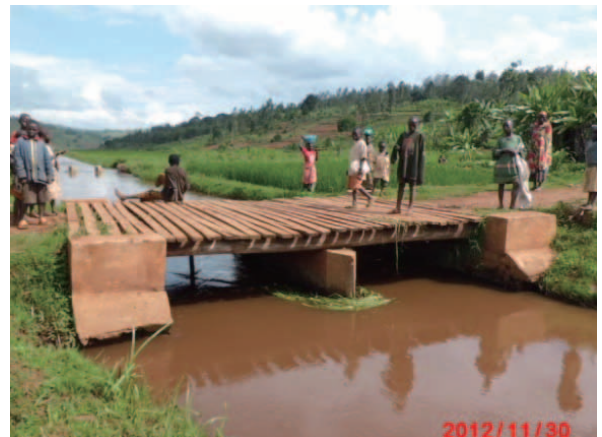
地区中央の排水路（用水源でもある）
