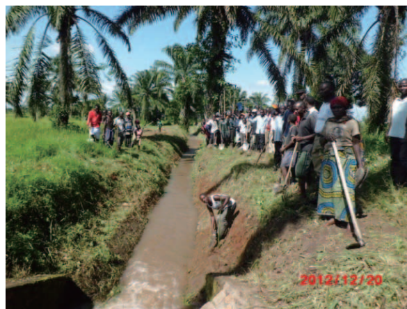
導水路の除草作業終了
