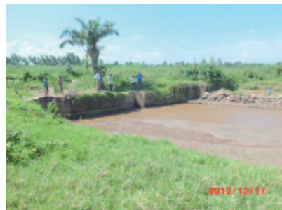
土砂吐・洪水吐制水門
