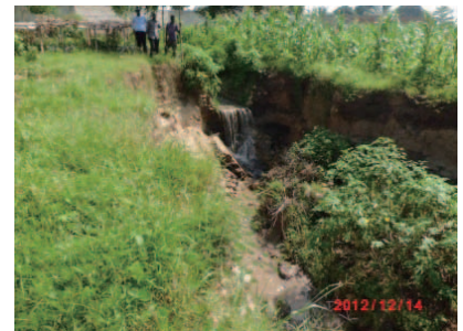
余水吐下流水路
