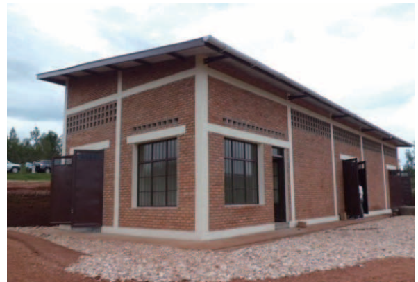
建設中の貯蔵施設
