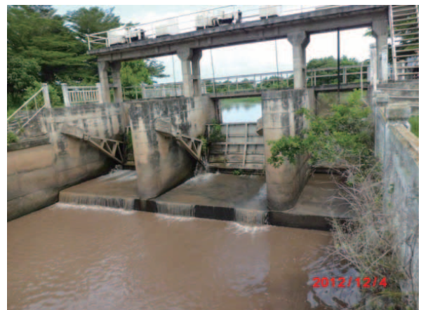
ムパンダ頭首工
