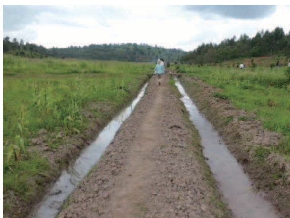
Kibuye 地区幹線水路と2次水路
