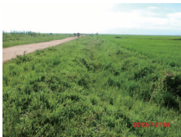
ムゲレロ地区内排水路
