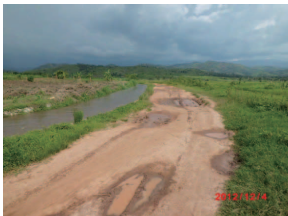
導水路管理用道路
