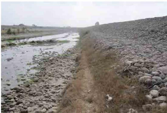
**Figura 3.2 Dique y protección de márgenes con gaviones en el río Chincha**
