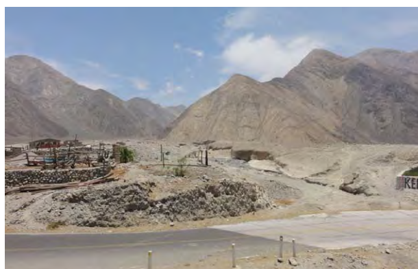
Figura 1.3.11 Situación de la deposición de sedimentos en el río San Francisco (obstrucción de los canales de riego a causa del desastre. Las paredes de la carretera son los sedimentos de tierra y arena de ese entonces)
