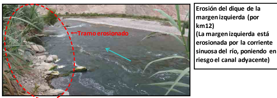
Figura 3.1.6-3 Condiciones locales relacionadas con el Desafío 2 (Río Camaná)
