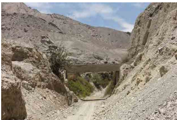
Figura 3.1.8-14 Situación de la deposición de sedimentos en el Río San Francisco (obstrucción de los canales de riego a causa del desastre. Las paredes de la carretera son sedimentos de tierra y arena de ese entonces)
