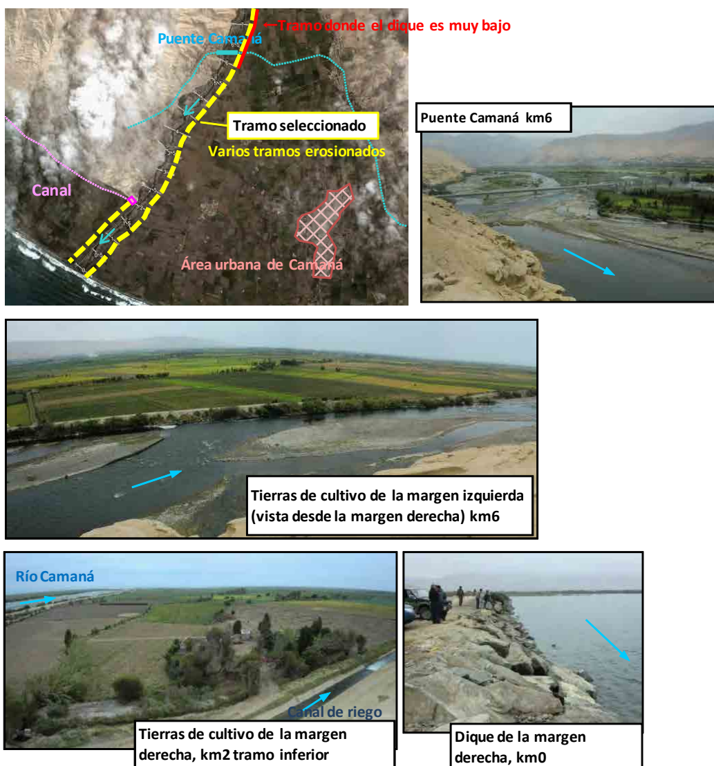
Figura 3.1.6-2 Condiciones locales relacionadas con el Desafío 1 (Río Camaná)
