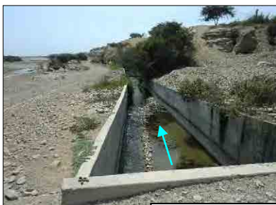
Canal de agua
