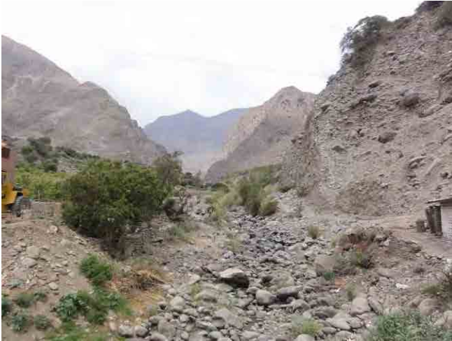
Figura 3.1.8-8 Tierras andesíticas y basálticas derrumbadas
