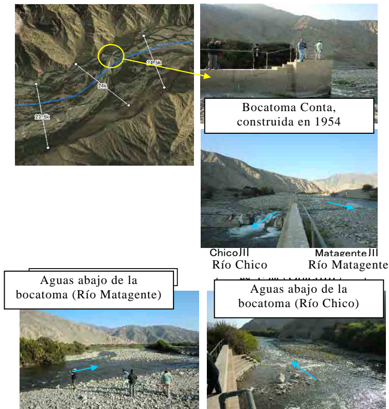
Figura 3.1.6-6 Condiciones locales relacionadas con el Desafío 1 (Río Chinchá)
