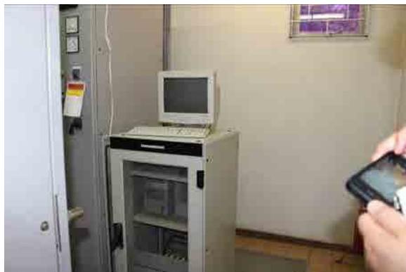
Figura 4.2-3 SAS na Subestação de Rio Branco do Sul (Fonte: Foto pela Equipe de Pesquisa)
