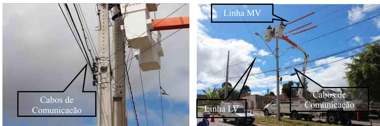
Figura 6.4-7 Trabalho de Instalação no poste
