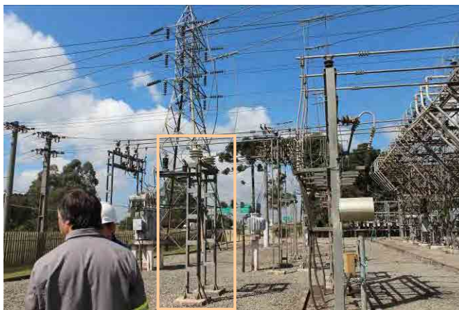
Figura 6.4-9 Instalação do CVT na subestação existente (Fonte: Foto tirada pela Equipe de Pesquisa)
