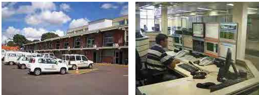
Figura 4.9-6 Centro de Controle de Distribuição e Caixa de Controle
