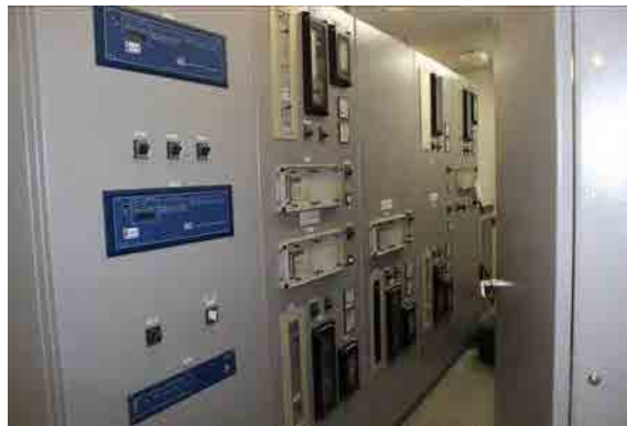
Figura 4.2-4 Painel de Relé na Subestação de Rio Branco do Sul (Fonte: Foto pela Equipe de Pesquisa)
