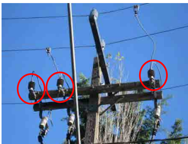
Figura 4.3-10 Supressor de surtos tipo Polímero e ZnO
