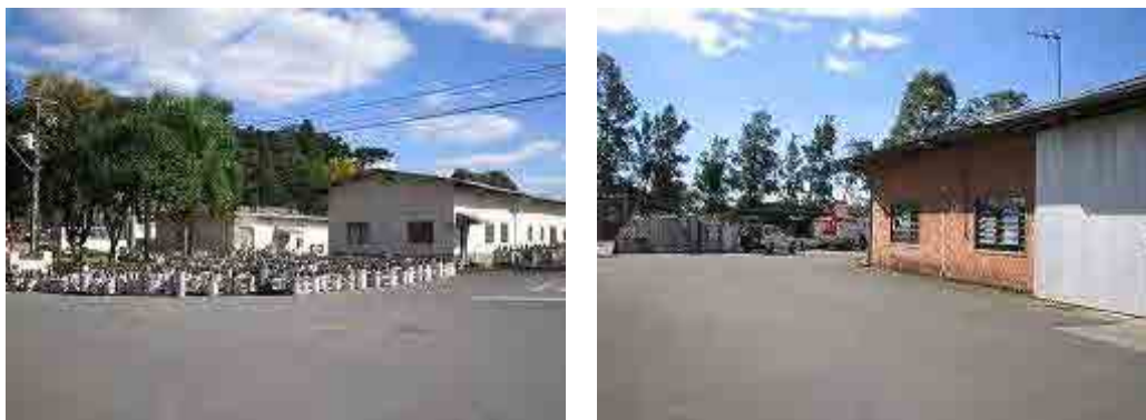
Figura 4.9-9 Edifício de Manutenção de Transformador e Edifício de Testes de Medidor
