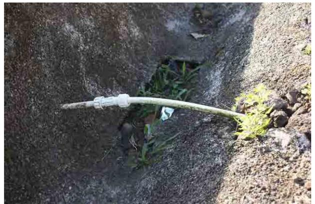
写真⑯：地表に露出した給水管
