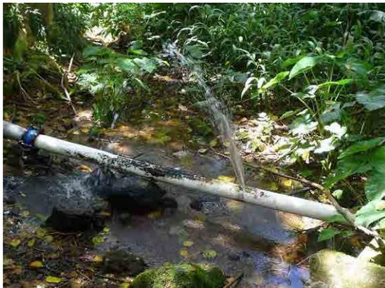
写真㉘：タパタパオ水源導水管の空気抜き穴からの漏水。このような管に穴を開けただけの空気穴が多く見られ、漏水の原因。
