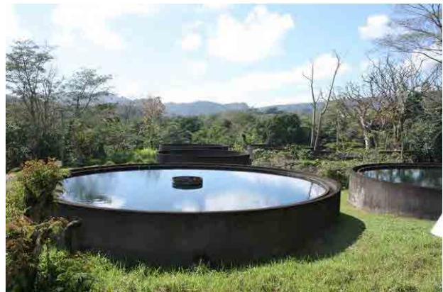
写真⑩：フルアソウ浄水場（緩速ろ過式）
