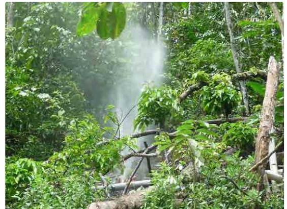
写真㉙：アラオア湧水からの導水管の漏水。高い水圧がかかっており、吹き上げるようにして漏水している。
