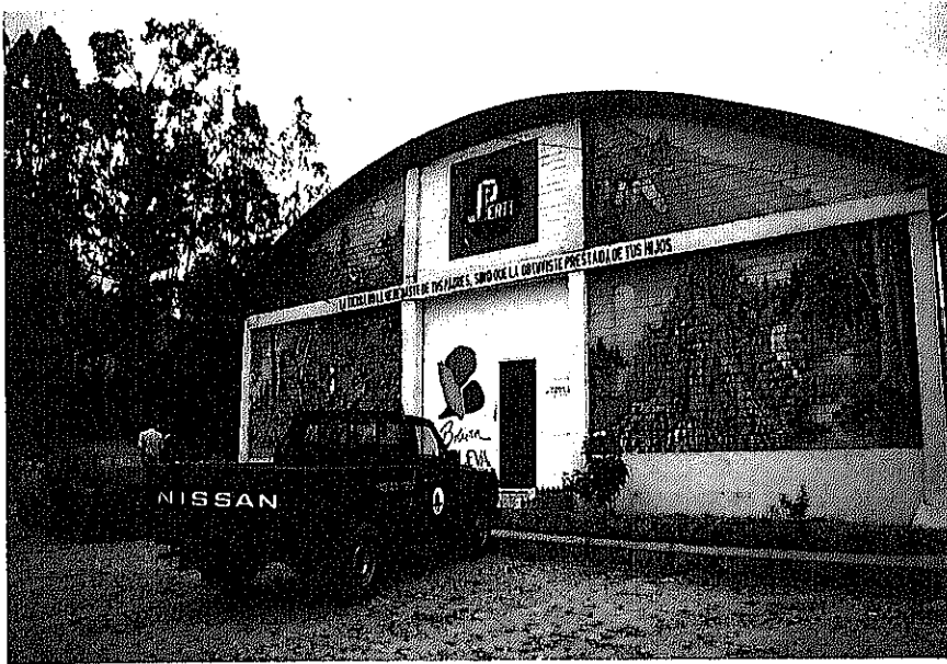
PERTTの本部。 体育館のような構造で、中が 部屋に仕切られている。エア コンは据付られていない。
