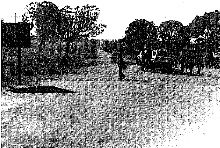
Mbutuy (国道5号線と国道10号線の分岐点)より国道10号線方向を望む。国道10号線は未舗装であり、降雨の翌日は補修のため閉鎖される。
