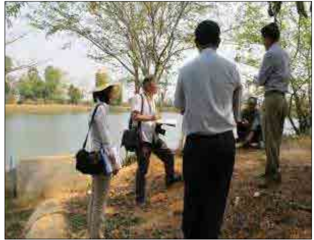
シェムリアップ州の共有池(左:取替えた土管)
