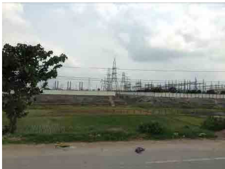
写真: サイト東 2km にある変電所
