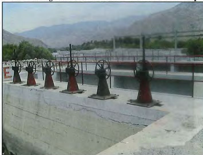
FOTO N° 10: Ca-04 - Margen Derecha Río Cañete – Bocatoma Nuevo Imperial (24+750)
