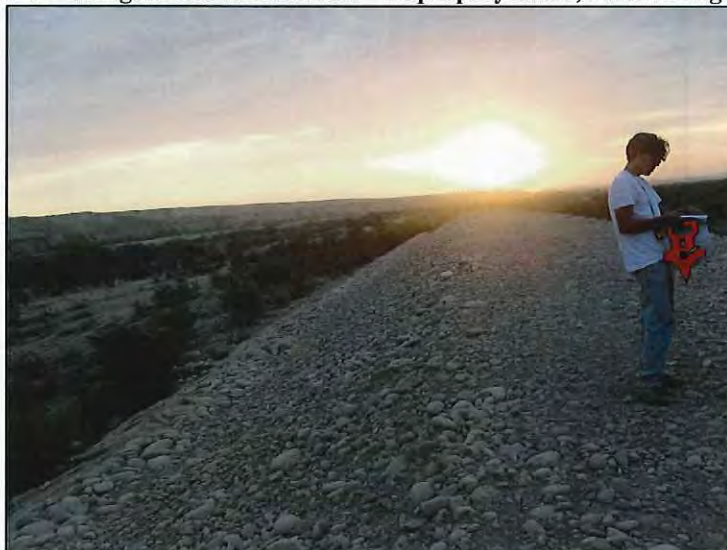
FOTO N° 45: Pi-06 - Margen Derecha Río Pisco – Dique proyectado, Poza de Regulación (36+300)
