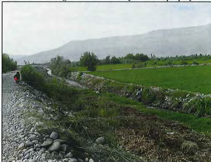
FOTO N° 68: MC-07 – Margen Derecha Río Majes – Fin Dique proyectado (66+520)
