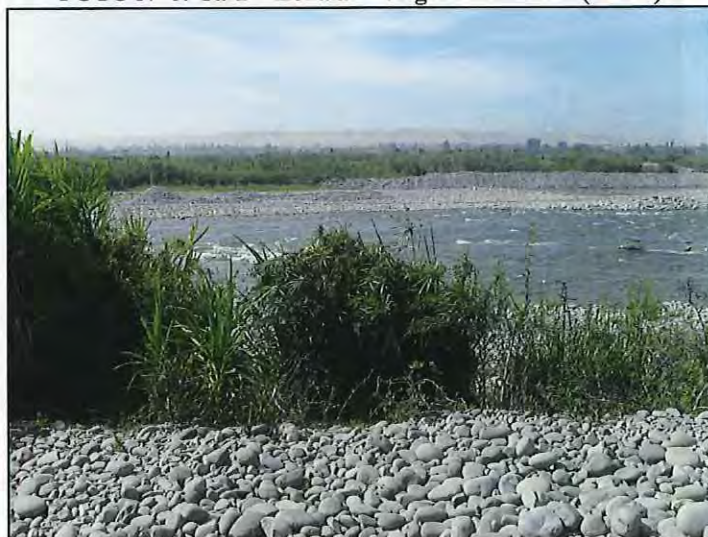
FOTO N° 6: Ca-2 – Zona a Proteger Río Cañete (6+750)
