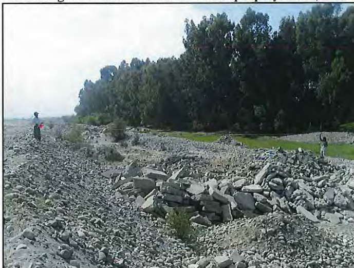
FOTO N° 18: Ch-01 - Margen Derecha Río Chico – Fin dique proyectado, zona aforestar (4+900)
