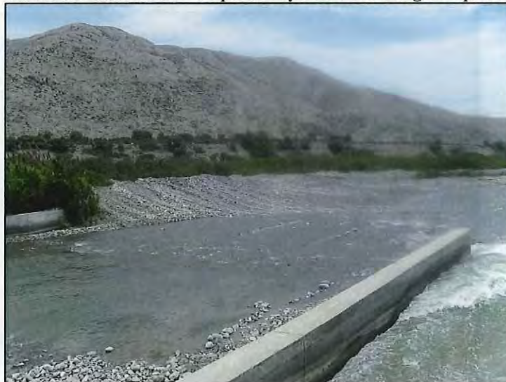
FOTO N° 11: Ca-04 - Río Cañete – Dique a Proyectar en la Margen Izquierda (24+600)
