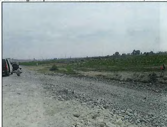
FOTO N° 35: Pi-02 – Margen Izquierda Río Pisco – Inicio de forestación, zona a expropiar (6+400)
