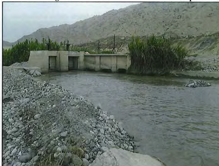
FOTO N° 19: Ch-02 - Margen Derecha Río Chico – Bocatoma Pampa de Ñoco (14+820)
