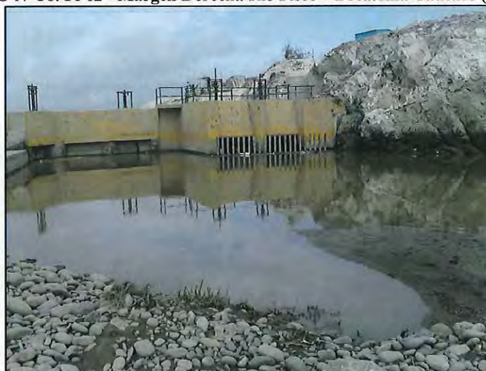
FOTO N° 36: Pi-02 - Margen Derecha Río Pisco – Bocatoma Caucato (6+740)
