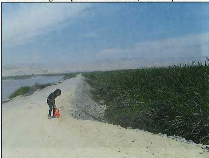
FOTO N° 46: MC-01 – Margen Izquierda Río Camaná, Inicio Dique de Protección (0+000)
