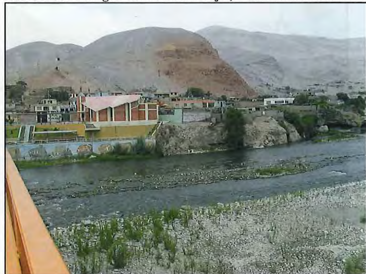
FOTO N° 60: MC-06 - Margen Derecha Río Majes, Distrito Punta Colorada (59+900)
