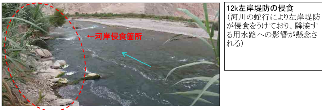
図-3.1.6-3 課題2に関する現地状況 (カマナ川)
