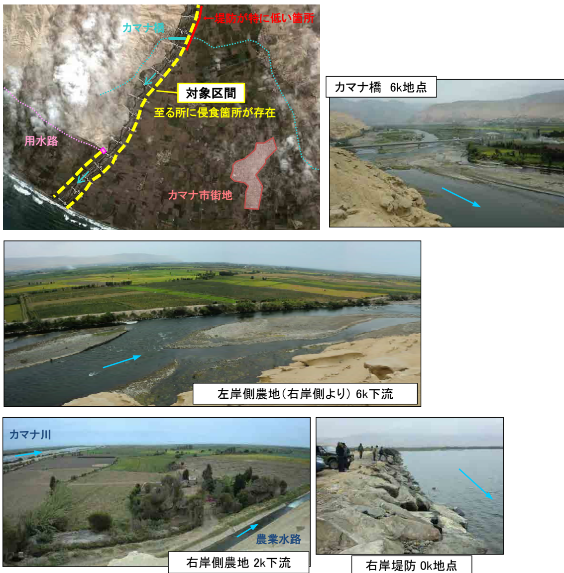
図-3.1.6-2 課題 1 に関する現地状況 (カマナ川)
