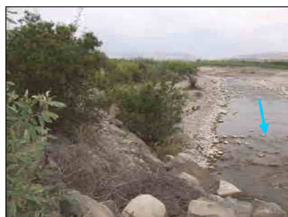
再構築された堤防の状況
