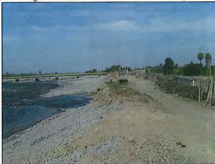
FOTO N° 4: Ca-01 - Margen Derecha Río Cañete – CC.PP. Pedro Cruz, zona a expropiar (4+740)
