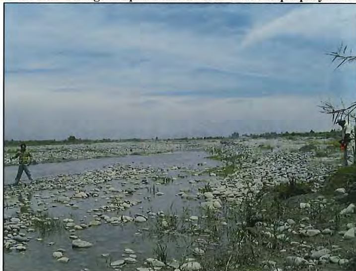
FOTO N° 37: Pi-03 – Margen Izquierda Río Pisco – Inicio dique proyectado (12+400)
