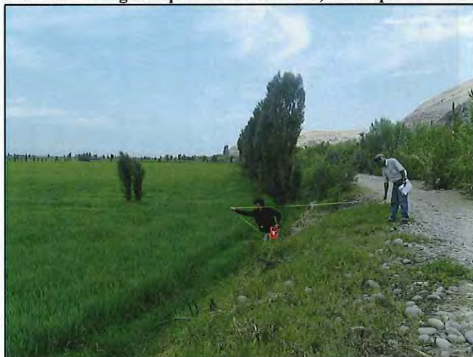
FOTO N° 48: MC-01 – Margen Izquierda Río Camaná, Fin Dique de Protección (4+500)
