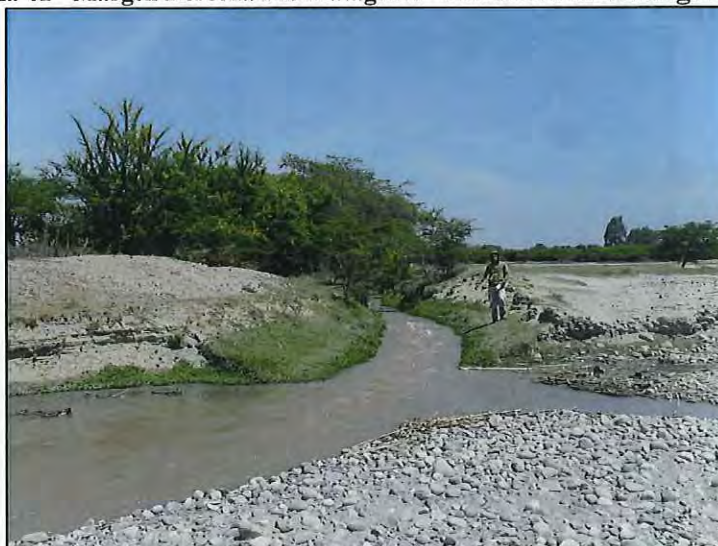
FOTO N° 30: Ma-02 - Margen Derecha Río Matagente – Estructura de Descarga La Altura (9+990)
