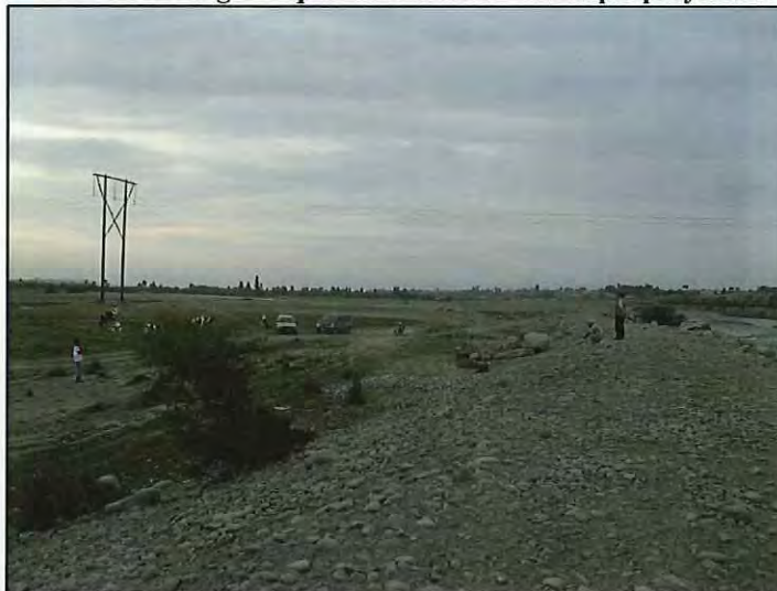
FOTO N° 43: Pi-05 – Margen Izquierda Río Pisco - Fin dique proyectado (26+700)
