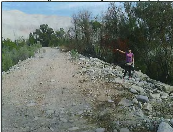
FOTO N° 64: MC-07 – Margen Derecha Río Majes – Inicio Dique proyectado (65+400)
