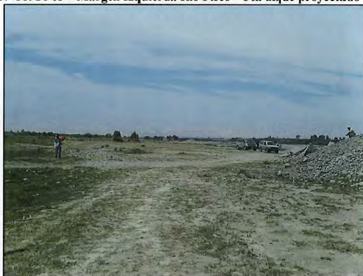
FOTO N° 38: Pi-03 – Margen Izquierda Río Pisco – Fin dique proyectado (13+900)
