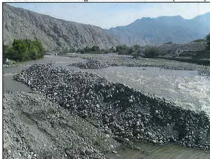
FOTO N° 24: Ch-03 – Aguas arriba Partidor Conta (> 24+000)
