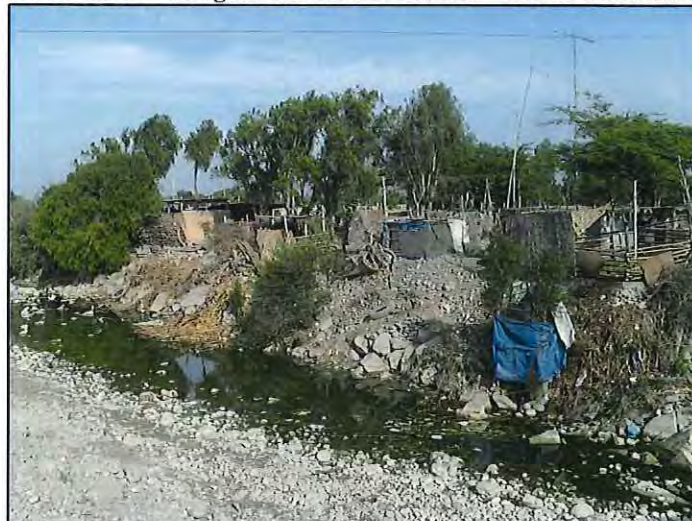
FOTO N° 3: Ca-01 - Margen Derecha Río Cañete – CC.PP. Urbanito (4+500)
